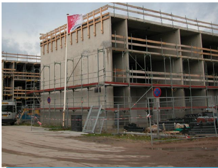
Figuur 8 Het nieuwe Leo Polakhuis in aanbouw.
